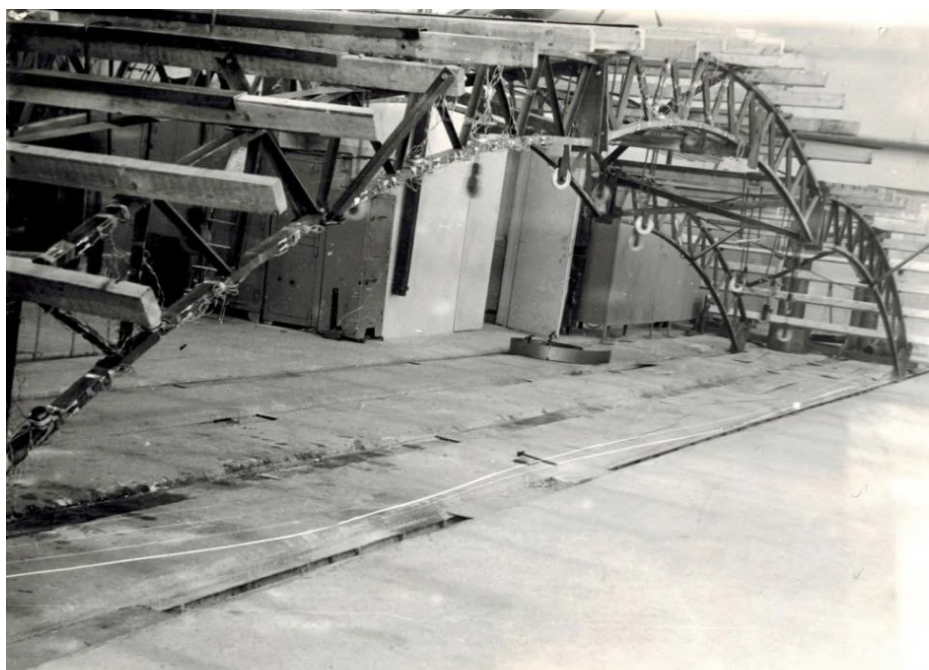
Рис. 5. Схема вертикального подъёма арочного блока из двух арок, состоящих из трёх отправочных элементов
