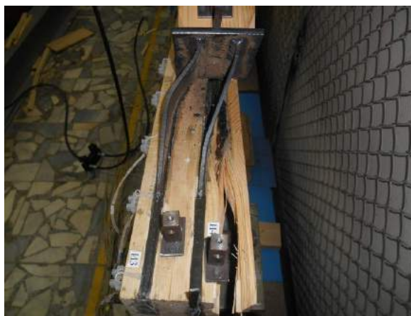
Рисунок 5. Разрушение опорного узла из-за потери устойчивости ребер
